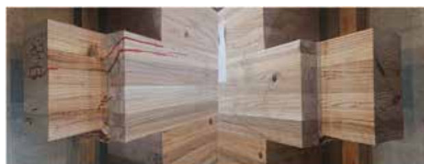
試験終了後の梁端部 No.2
