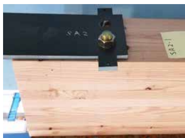
ボルトの破断
