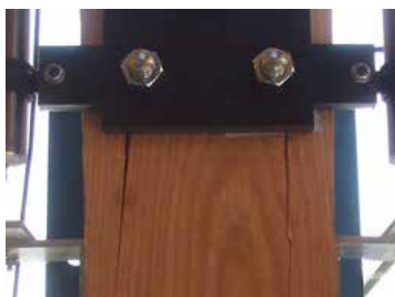
木材の割裂破壊
