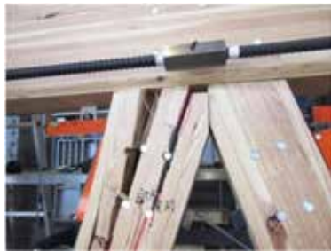
1/75rad 正側加力時引張ブレース割裂破壊
