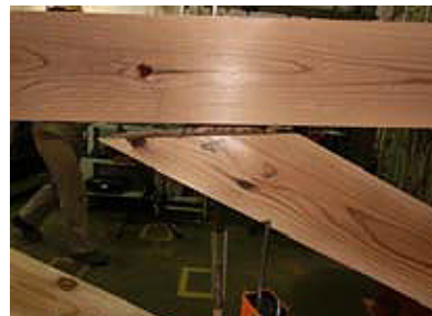
斜材接合部の離れ
