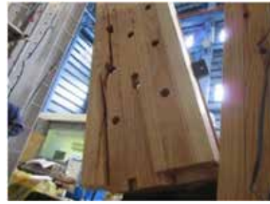
1/50rad 正側加力時引張ブレース割裂破壊
