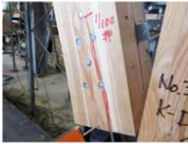
1/100rad 負側加力時引張ブレース割裂破壊
