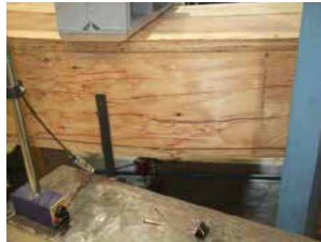
ウェブの曲げ破壊（試験体 3）
