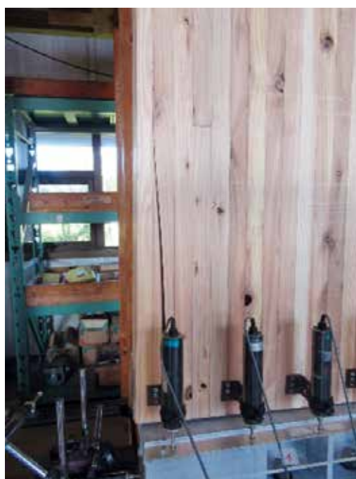
写真 2 LSB 埋め込み付近の部材の割裂破壊
