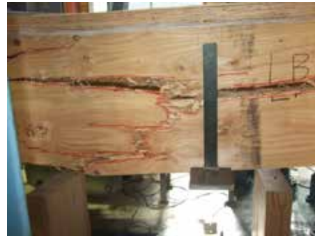
ウェブの曲げ破壊（試験体 2）
