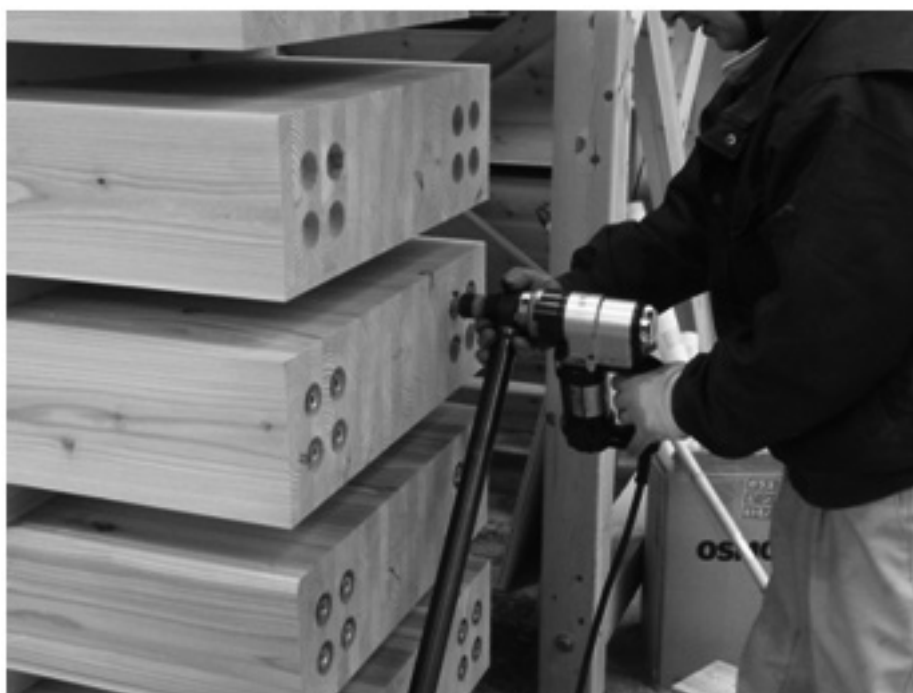
写真 1 LSB の施工状況
