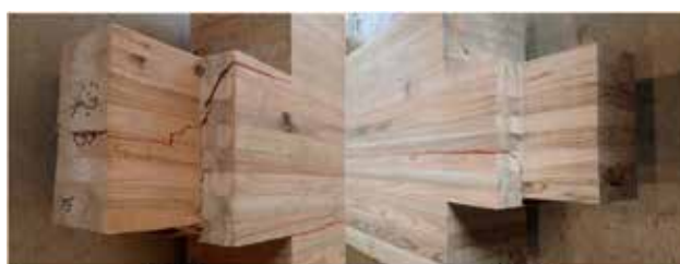
試験終了後の梁端部 No.3
