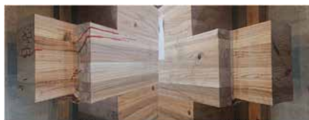
試験終了後の梁端部 No.2
