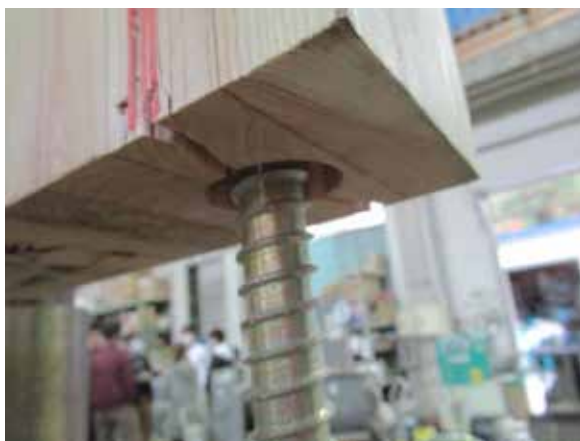
写真 2 LSB 引き抜けによる周辺部材の破壊・ LSB 埋め込み付近の部材割裂破壊
