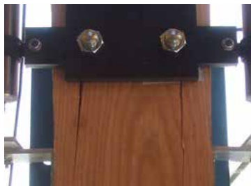
木材の割裂破壊
