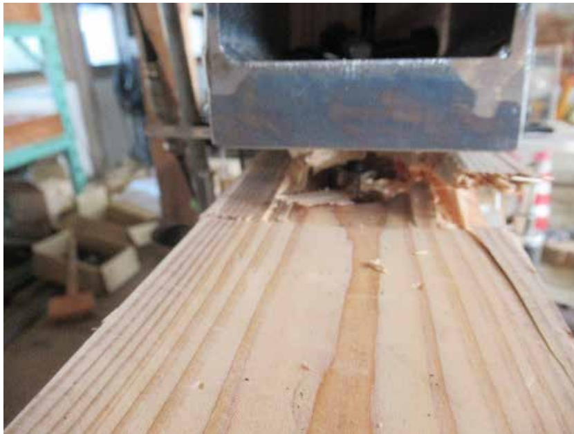
写真 2 引張側ハイテンションボルトの破断
