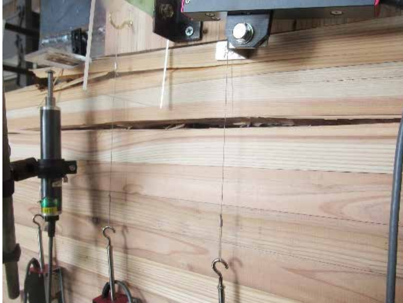
写真 1 柱部材におけるせん断受け金物の取り付けビス位置からの横引張割れ
