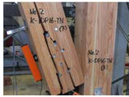
1/100rad 正側加力時引張ブレース割裂破壊
