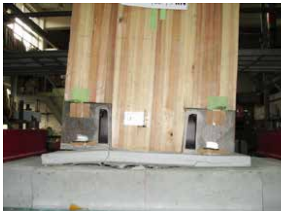
ベースモルタルのひび割れ
