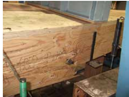
ウェブの曲げ破壊 (試験体 1)
