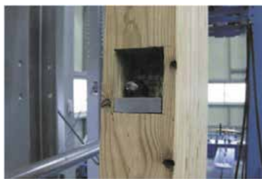
引張側ボルトの伸び・破断
