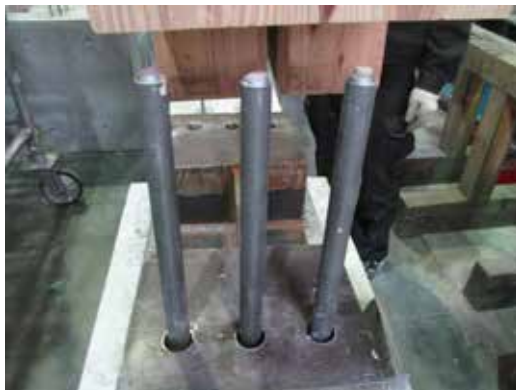
柱脚金物の曲げ変形
