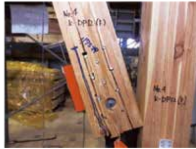
1/50rad 負側加力時引張ブレース割裂破壊
