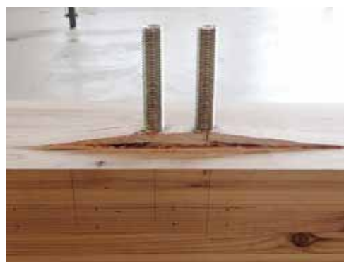
接合具の引抜け破壊
