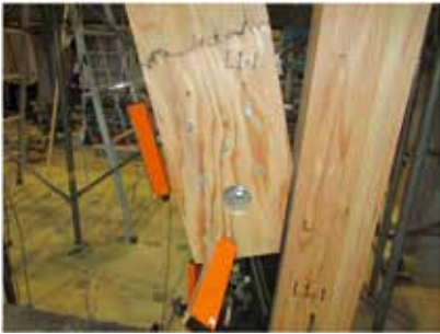
最大変形時のブレース端部
