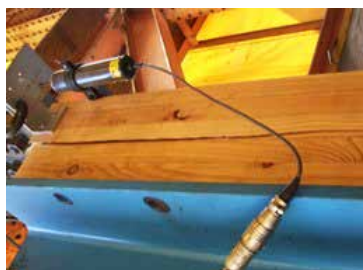
木材の割裂破壊
