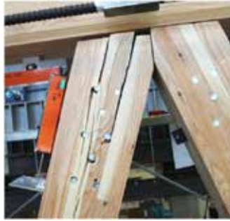
1/100rad 負側加力時引張ブレース割裂破壊
