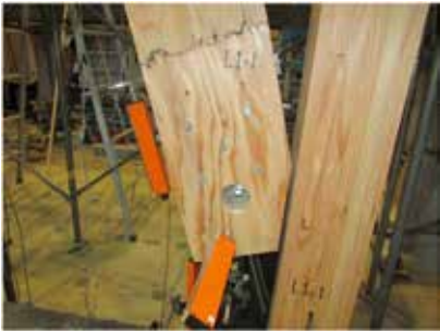
最大変形時のブレース端部
