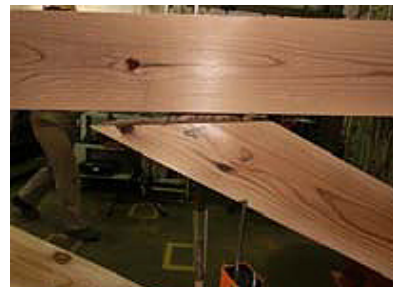
斜材接合部の離れ
