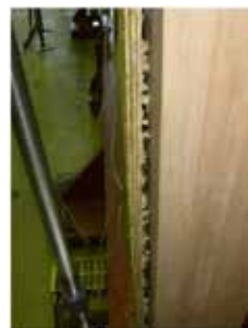
パンチング破壊した釘接合部（同）
