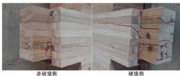
試験終了後の梁端部 No.1
