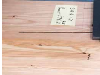
木材の割裂破壊
