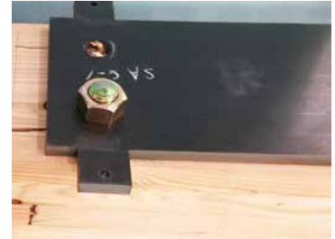
ボルトの破断
