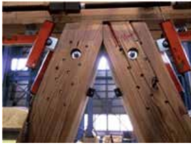
1/75rad 正側加力時引張ブレース割裂破壊
