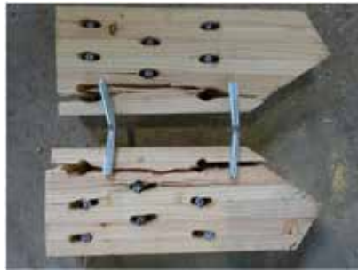
ドリフトピンの破断の様子
