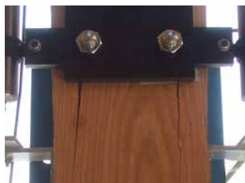
木材の割裂破壊
