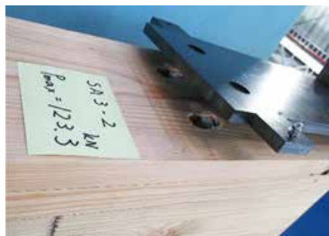
ボルトの破断
