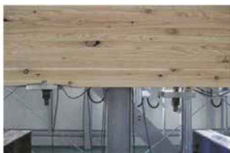
柱座金の柱側面へのめり込み
