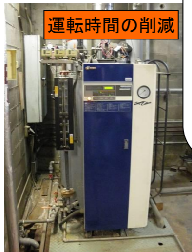
水冷から空冷へ入替
