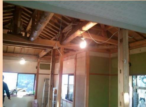
解体工事も順調に進み...
