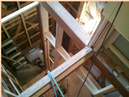
階段室も新しくします
