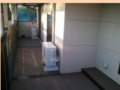
バルコニーの床と屋根も新しく取り換えました
