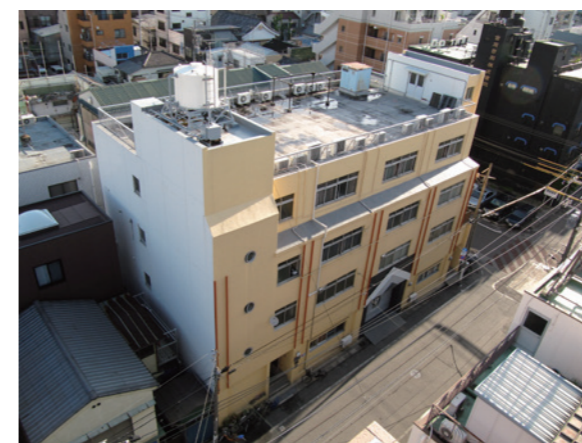
解体前の旧施設
