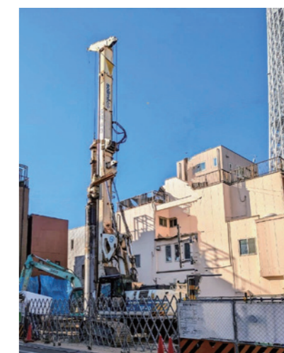
工事中のマルチドリル
