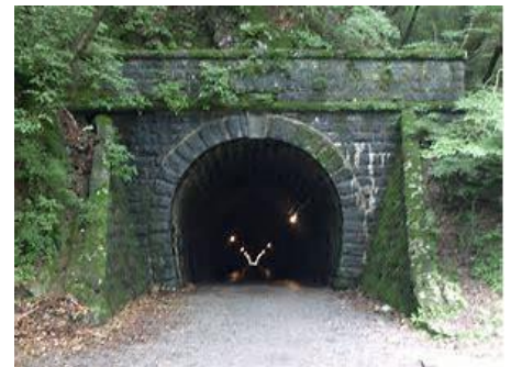
天城トンネルを通り天城越え
