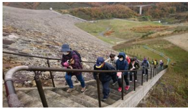
600段の摺上川ダム階段
