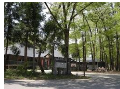
三島町生活工芸館
