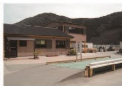
40tトラックスケール
