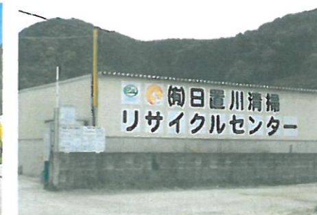
中間処理センター
