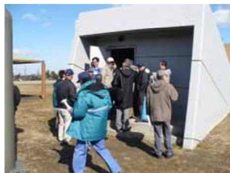
調圧水槽への階段入り口
