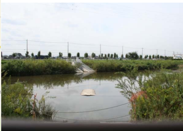
雨水流入口箇所から放流口を望む
