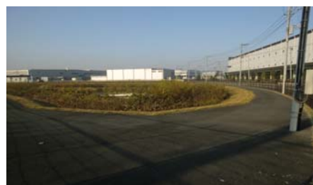
舗装は周囲通路、左が古川側
