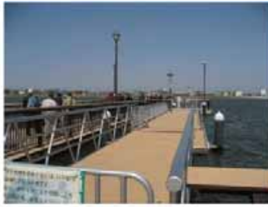
北池の浮き棧橋
