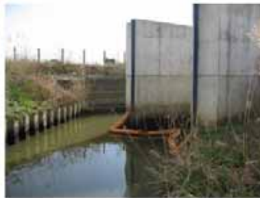
排水路中川吐口
