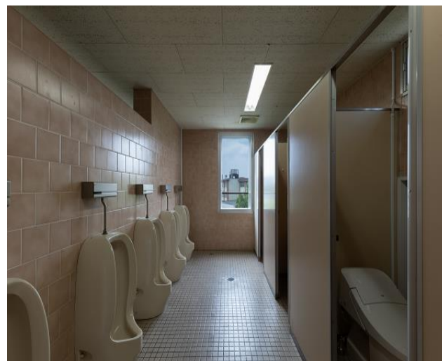
3階男子トイレ改修
