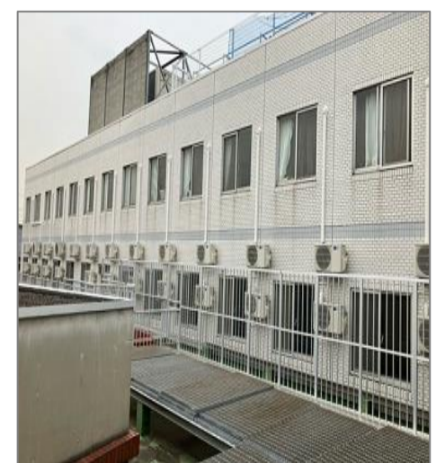
2～3階寮室エアコン全室更新
